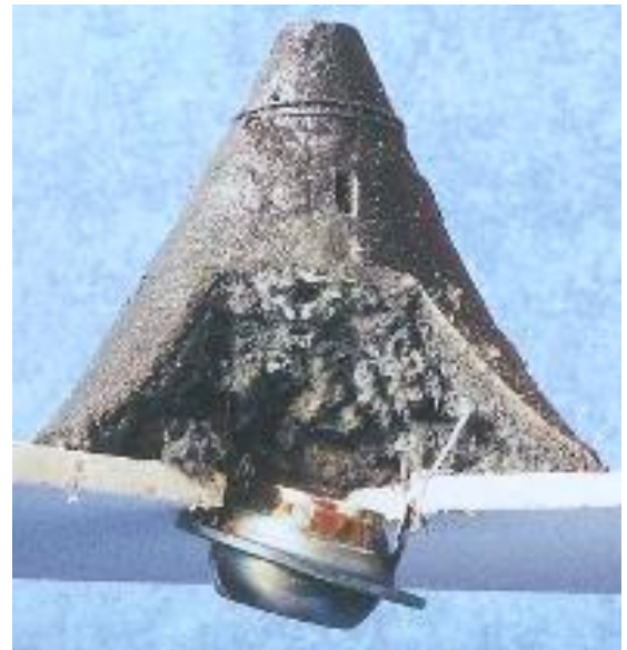
Na de brand (gedeeltelijk opengewerkt)
